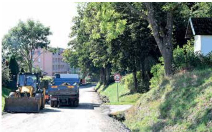
Začala rekonstrukce průtahu městem.
